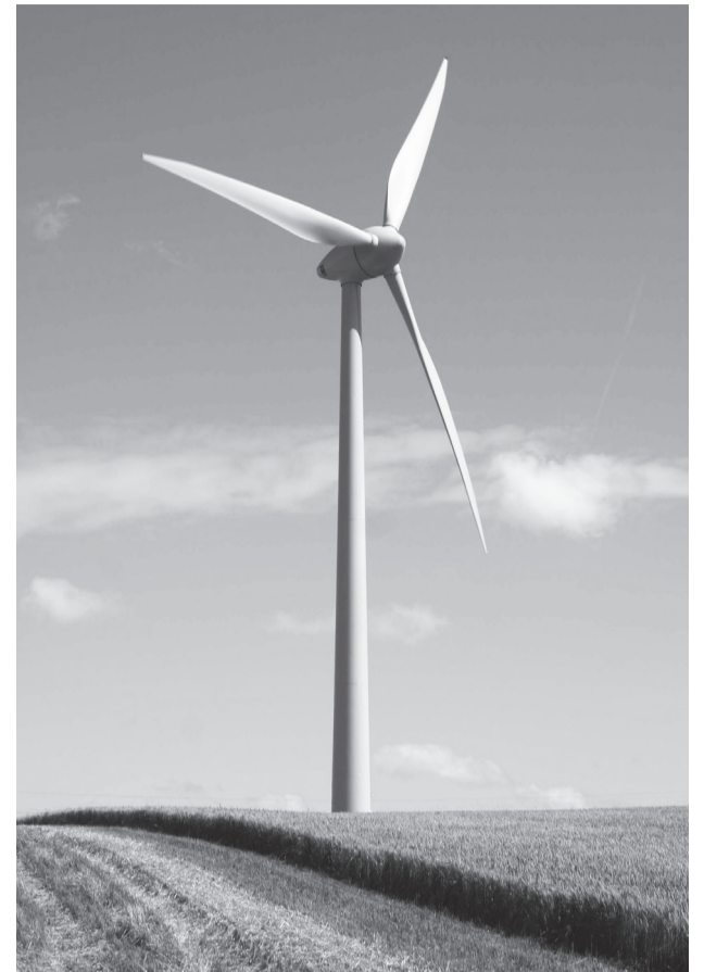
Eine Windturbine im Windpark Nibas in Frankreich. Ein Beitrag zur Energieautonomie.
